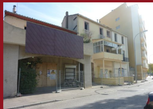
Foncier à démolir
